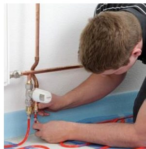
4. Heizleitungen mit Zentralheizungssystem verbinden
